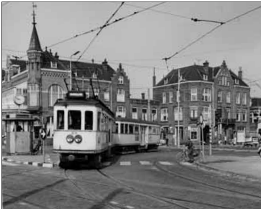
Limburgers 89+129 op aftakking van de Voorburgse lijn vanaf de Delftlijn op kruising Haagweg / Geestbrugweg met huisje voor de politieagent die de verkeerslichten regelde, die op 26 juli 1948 in werking werden gesteld. Op achtergrond Hotel-restaurant Kuys Witsenburg dat begin 1963 is gesloopt, 9 juli 1962. FOTO: C. CAMPAGNE
