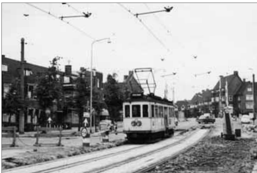
De Prinses Mariannelaan in Voorburg werd in 1959 geasfalteerd en de Geestbrugweg in Rijswijk in 1963. De 88 op Geestbrugweg tijdens asfaltering van die weg met op achtergrond de Geestbrug, 1 september 1963. FOTO: H.J. SOUËR
