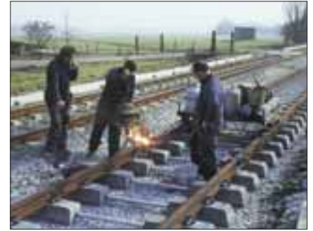
De trambaan langs de Delftweg werd in de jaren 1978-'80 in drie fasen vernieuwd. PCC-car 121.? rijdt over het al vernieuwde spoor richting Den Haag bij 's-Gravenmade, terwijl het spoor richting Delft wordt uitgebroken, 13 maart 1979. Het maken van een thermietlas tussen railstaven bij Driehuizen (Bouwlust), 20 maart 1979. FOTO's: J. BLOK
