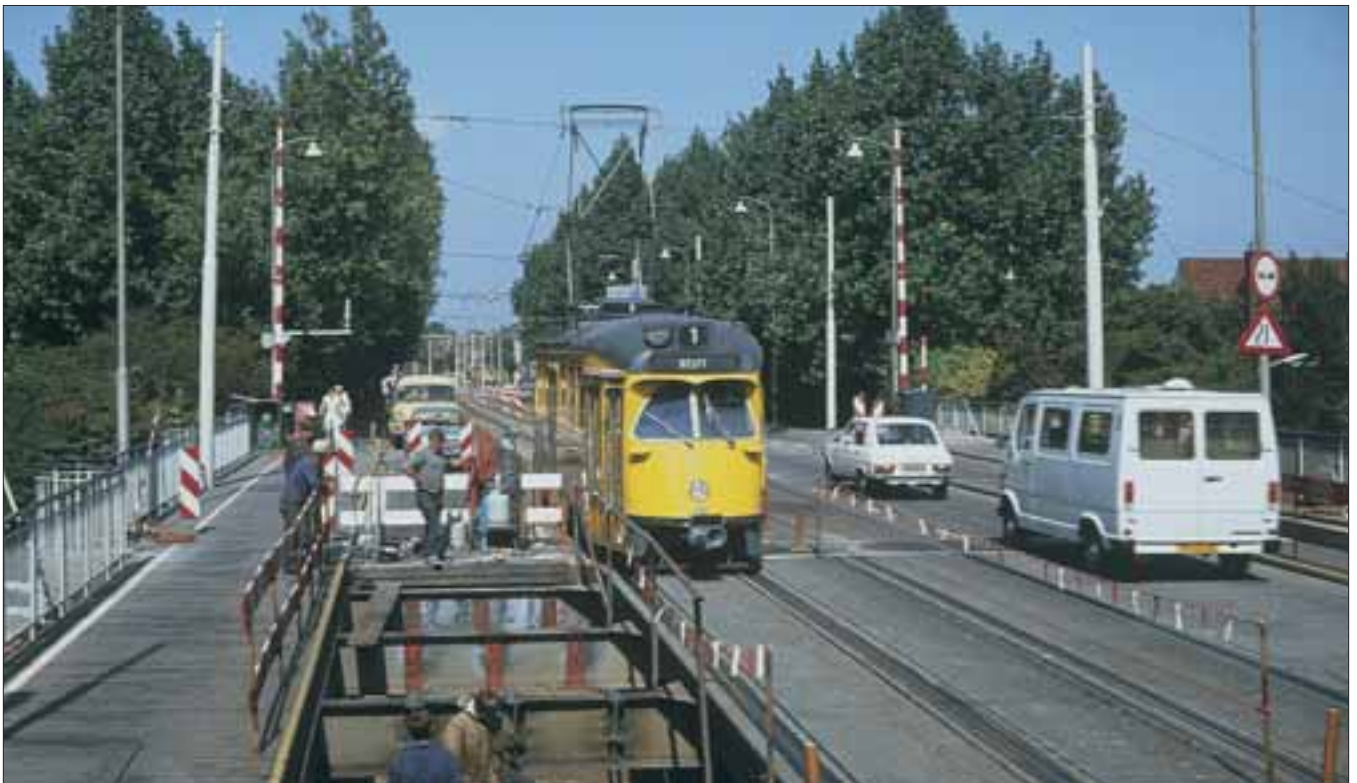
De Reineveldbrug kreeg in de periode 9 april t/m 1 oktober 1981 weer een opknopbeurt waarbij vanwege de afzetting direct naast de sporen kleinere PCC-cars serie 1101-1200 moesten worden ingezet. De 1141 zonder toeter op Reineveldbrug, 9 maart 1981. FOTO: J. BLOK
