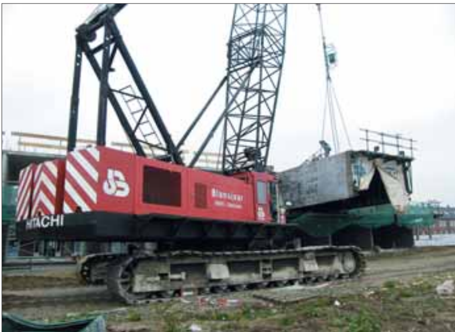
Het trekken van tunnelbekisting met een 100 tons KH500. De viersprong aan de tunnel hangt door middel van een compensatiecilinder aan het hijsblok van de kraan en zorgt ervoor dat de last in balans blijft.
