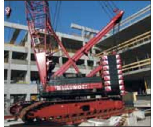
Betonelementen plaatsen met een Sumitomo SC900 van Zwagerman.
