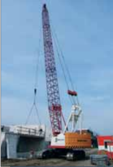
Betonelementen plaatsen met een Sumitomo SC900 van Zwagerman.
