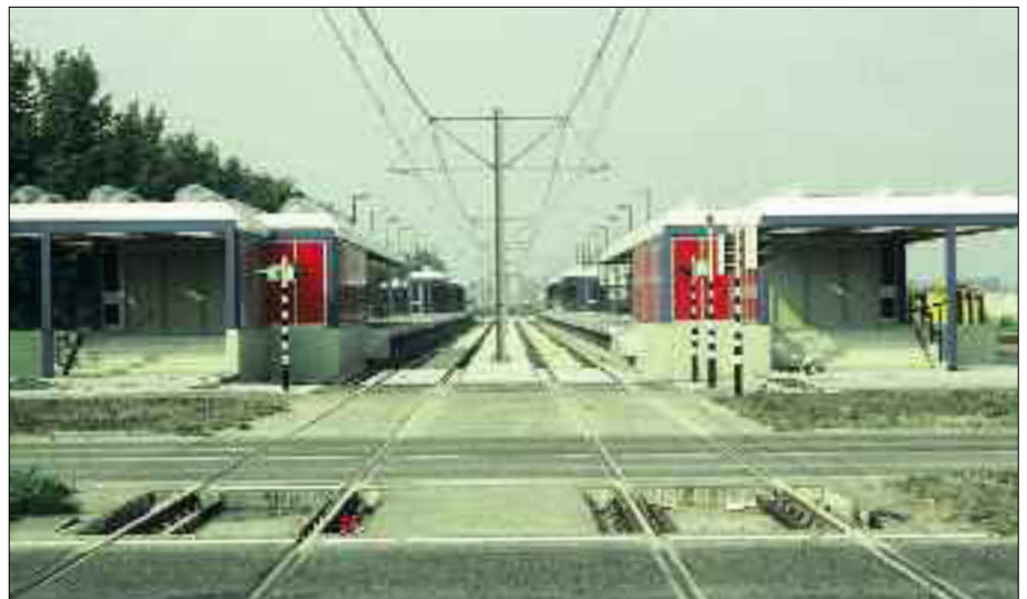
De infrastructuur van de sneltram in Rotterdam vertoont een fraaie symmetrie, en er is een supereenvoudige bovenleiding, systeem Rotgans. Oosterhof, 5 september 1982.
