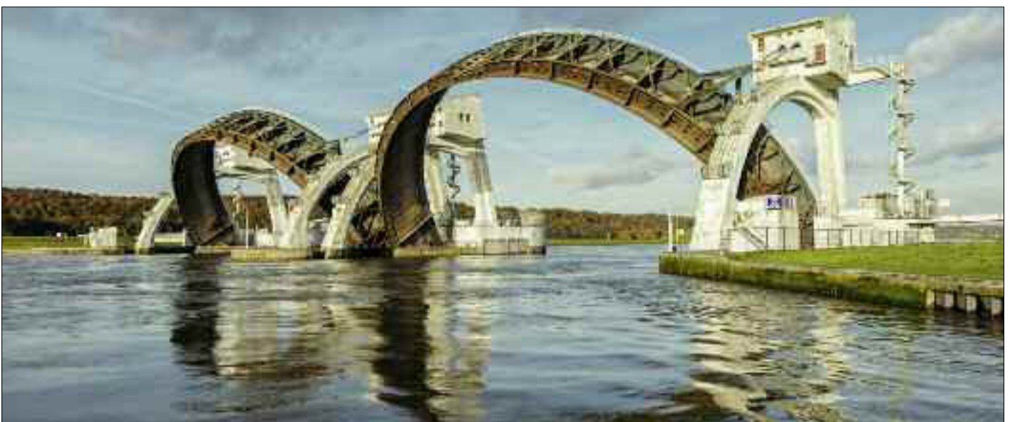
Siemens Nederland gaat de sluisen en stuwen in de Nederrijn en Lek renoveren. Hiermee is 100 miljoen euro gemoeid. De complexen bij Hagestein, Amerongen en Driel zijn na zo'n 50 jaar toe aan een grondige opknabbeurt. De renovatie moet in 2021 zijn afgerond. Na de renovatie moeten de stuwen weer 50 jaar meegaan. (Mdv/Foto Rijkswaterstaat)
